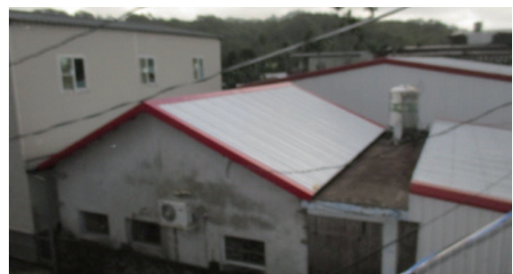
修繕後 - 屋頂煥然一新
